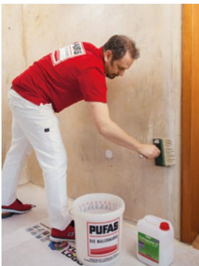
Der PUFAS Tiefengrund LF reguliert die Saugfähigkeit des Untergrunds für eine gleichmäßige Trocknung des Klebemittels
