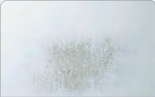
**Negativbeispiel:** Durchgeschliffene Stellen mindern das einwandfreie Finish, das gefordert ist. Durch den sichtbaren Kartonuntergrund ergibt sich eine unterschiedliche Saugfähigkeit und ein optisch uneinheitliches Bild. Beide Mängel können sich bei anschließenden Beschichtungs- und Tapezierarbeiten negativ auswirken.
