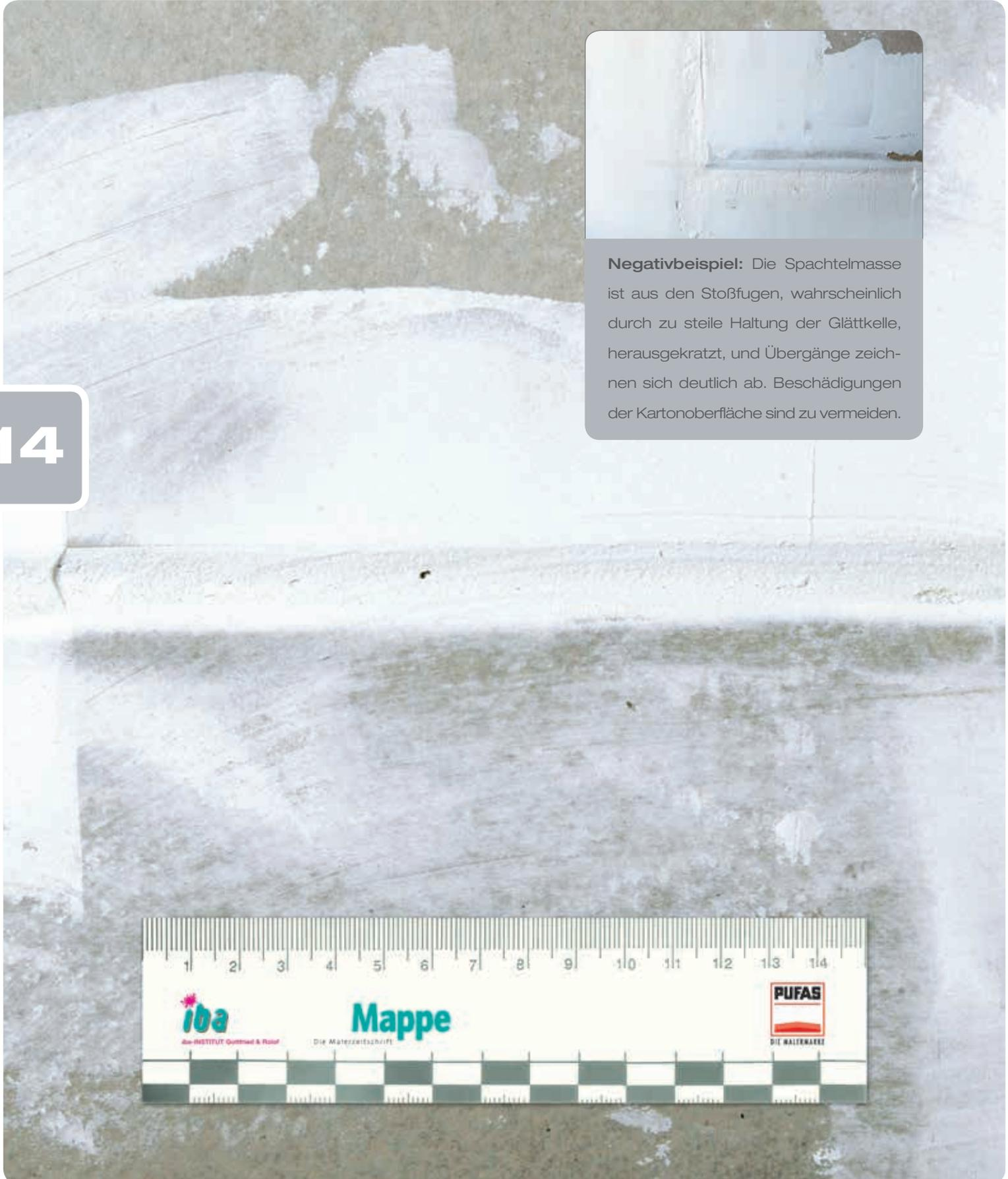
**Negativbeispiel:** Die Spachtelmasse ist aus den Stoßfugen, wahrscheinlich durch zu steile Haltung der Glättkelle, herausgekratzt, und Übergänge zeichnen sich deutlich ab. Beschädigungen der Kartonoberfläche sind zu vermeiden.
