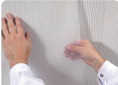
Das KOBAU microlith® Spachtelvlies in die noch nasse Spachtelmasse des pufamur Leichtspachtel LS 8 einlegen.
