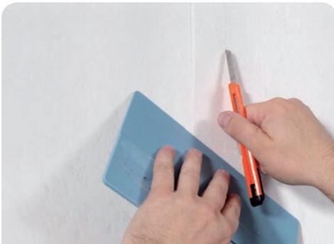
Anschluss der Vliesbahnen mit Doppelnahtschnitt herstellen und darauf achten, dass die Cutterklinge den Untergrund nicht beschädigt.
