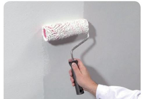
Nach vollständiger Durchtrocknung der Fläche PUFAS Grundierweiss GP 5 auftragen.
