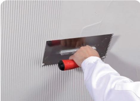
Die zu armierende Fläche gemäß VOB, Teil C DIN 18363 vorbereiten und anschließend den PUFAS pufamur Leichtspachtel LS 8 auf die Fläche auftragen und mit der Zahnkelle durchkämmen.
