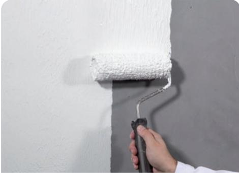
PUFAS Grundierweiss GP 5 mit deutlicher Schlepstruktur satt auf den Untergrund auftragen.
