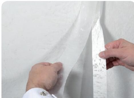
Die abgetrennten Kantenstreifen entfernen und den Nahtbereich mithilfe eines Kunststoffrakels schließen.
