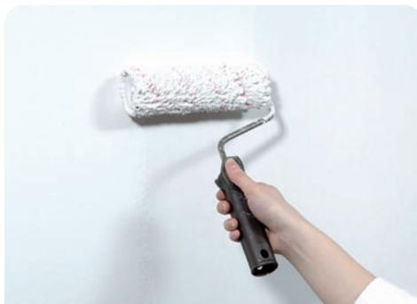
Dann nass in nass vollflächig PUFAS Grundierweiss GP5 auftragen. Nach der Durchtrocknung den Schlussanstrich aufstreichen.
