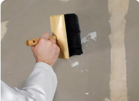
Oberflächen reinigen und mit Tiefengrund LF grundieren
