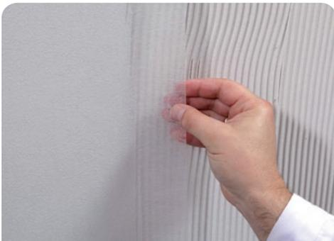
Die Folgebahn mit einer Überlappung von rund 5 cm anlegen, mittig leicht andrücken und ebenfalls bis ca. 5 cm zur Naht verpressen.
