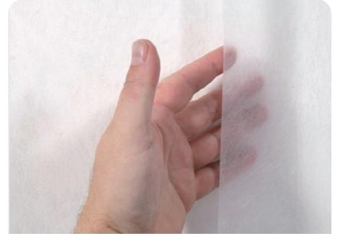
Eine nächste Bahn mit PUFAS GP5 beschichten und das KOBAU Armiera® Anstrichvlies mit 5 cm Überlappung einlegen.
