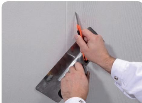
Doppelnachtschnitt mit dem Cuttermesser setzen und abgetrennte Vliesstreifen entfernen.
