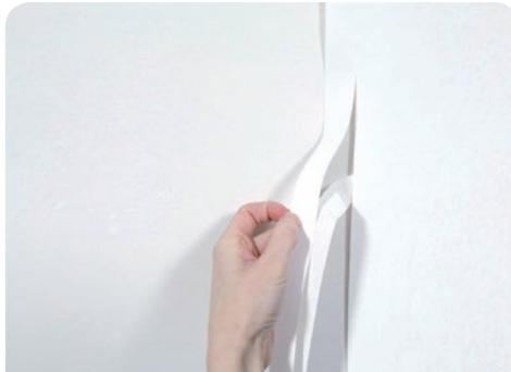
Ggf. Nahtschnitt ausführen und die Reststreifen entfernen. Im Nahtbereich heraustretenden Kleber mit einem feuchten Tuch abwischen.
