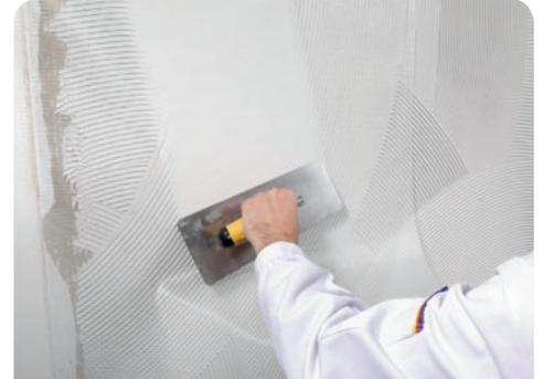
Das KOBABU Glasgitter-Gewebe 5/5 in die noch nasse Spachtelmasse des pufamur Leichtspachtel LS 8 einlegen. Die Zahnkellenstruktur verpressen.
