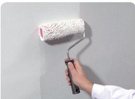
Nach vollständiger Durchtrocknung der Fläche PUFAS Grundierweiss GP 5 auftragen.
