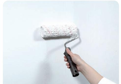
Die Zwischenbeschichtung erst nach Durchtrocknung (min. 12 Stunden) mit Grundierweiß GP 5 auftragen. Abschließend Dispersionsfarben aufstreichen.
